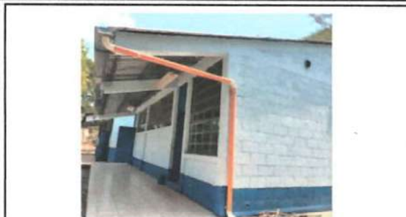
Foto 1: Preparación de la superficie y aplicación de pintura a dos manos, en paredes interiores y exteriores del establecimiento.
