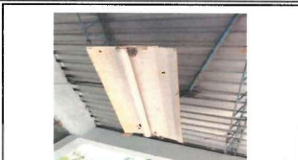
Foto 2: Sustitución de sistemas de iluminación: Lámparas
